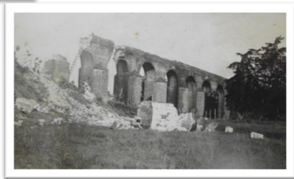
Figura I.11. Acueducto de Píñula: a. Fotografía de 1878; b. Vista del acueducto con los volcanes de fondo; c. Vista general; d. Algunos problemas que presentó con los terremotos de 1917 y 1918. Tomado de Pérez y Gall 1970; Chajón 2006; Álbum fotográfico de Jorge Ubico 1943 y To 2006.
